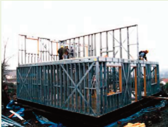
Figure 3 · Construction typique à ossature d'acier léger
