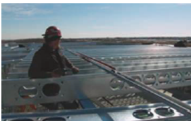
Les éléments de charpente en acier formé à froid mettent à profit la résistance de l'acier léger à fort contenu recyclé.
