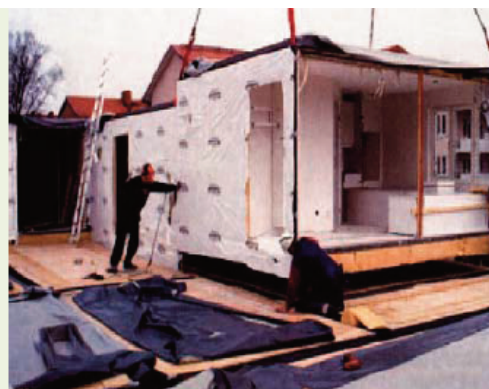
Figure 1 · La préfabrication peut réduire l'impact des travaux sur le site.
