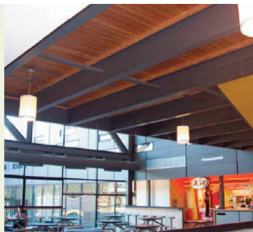
Figure 3 · Le centre des étudiants du Campus de Scarborough de l'Université de Toronto intègre de l'acier récupéré.
