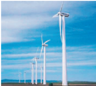
Cent tonnes d'acier sont utilisées pour assurer la viabilité financière et la résistance d'une tour à turbine éolienne de 60 mètres.
